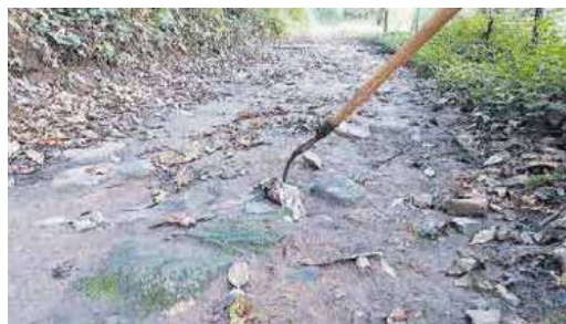
Un vecino señala con una herramienta restos de toallitas en el entorno de una tapa de registro en la senda del Bispo. | Fdv
