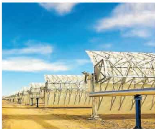
Llegan también al gigante asiático Central termosolar de canal parabólico de Delingha (China), construida por TSK
