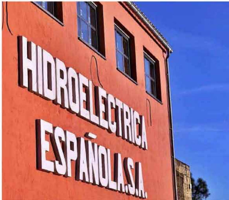
Parte de la antigua Hidroeléctrica ya se ha rehabilitado. / MANU REINO
