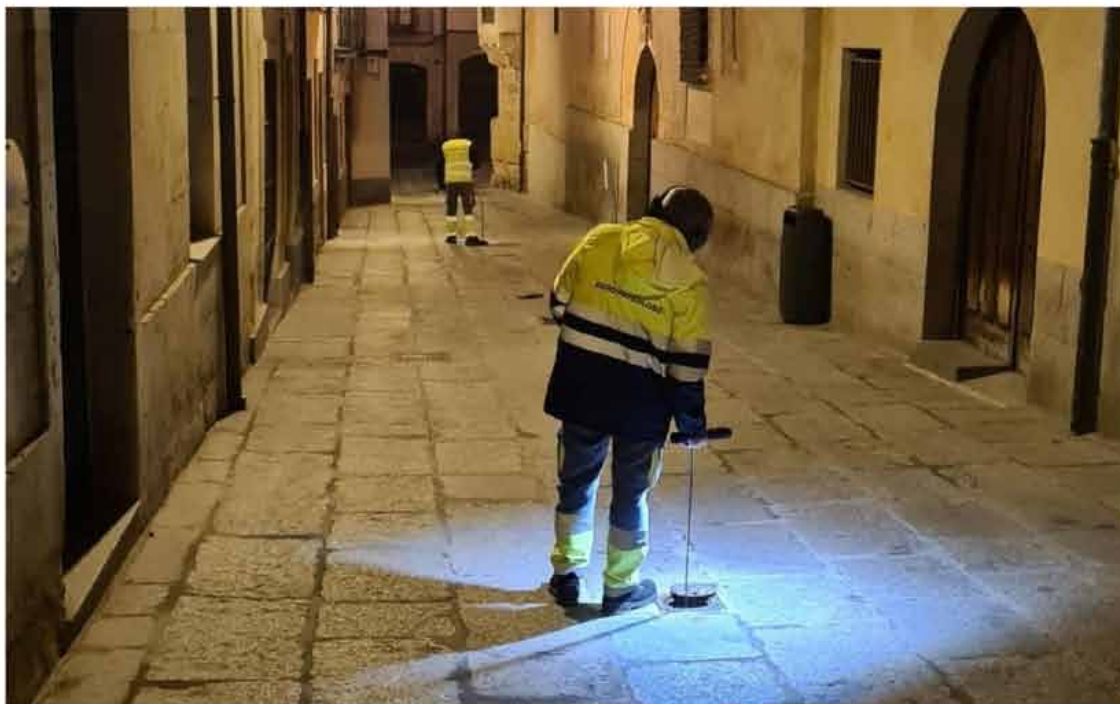
Control de fugas en la red de abastecimiento de agua de Salamanca.
